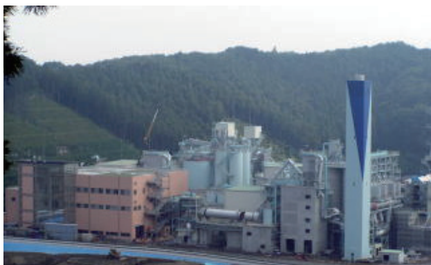
(日の出町二ツ塚処分場内にあるエコセメント工場)
